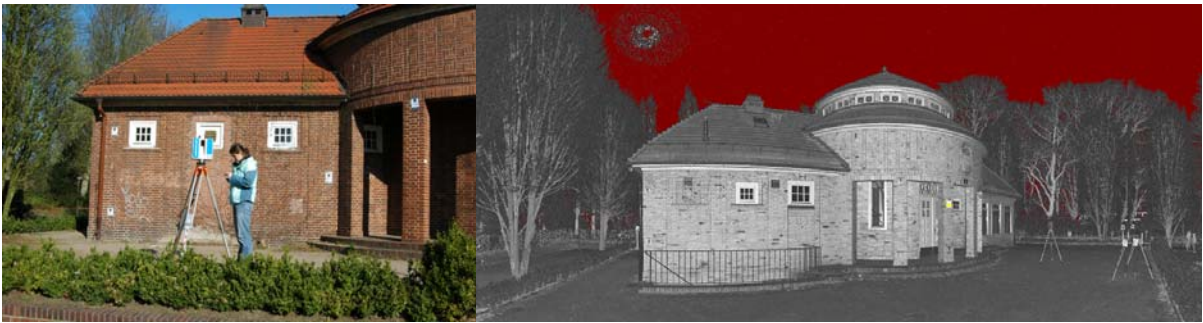
Laserscanning mit dem IMAGER 5010 (links) und 2D-Intensitätsbild des Scanners von der Trinkhalle (rechts)
