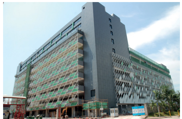
Abb. 2 Großladeanlage für Busse / Yueliangwang Station
