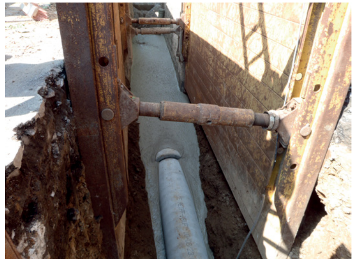
Abb. 4 Einbringen von ZFSV in den verbauten Graben
