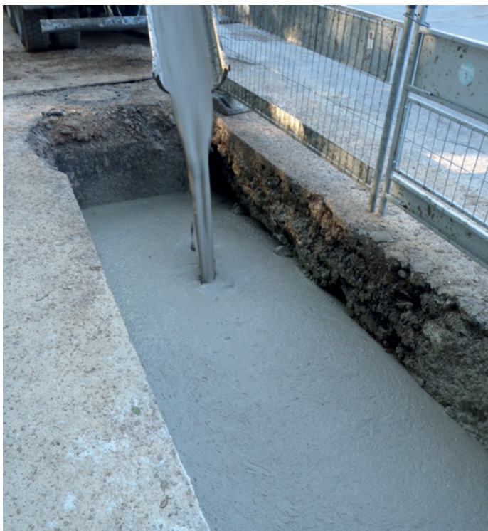
Abb. 1 Einbringen von ZFSV in den offenen Graben
