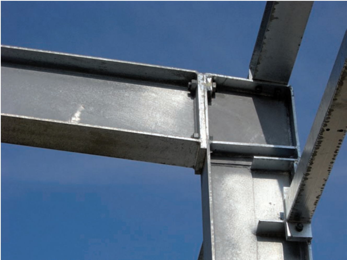
▲ Typische Stahlbausituation Foto: Krahwinkel
